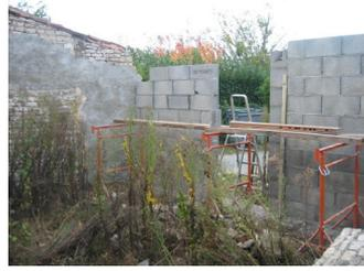
et les côtés qui vont porter le linteau, sont remonter. De plus la façade pour la partie 3 et monter, avec ici aussi la place pour une fenetre et une porte.
