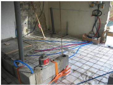
**A peu près** en milieu il y a le début d'un mur pour supporter les poutres, par ce que après la tôle ondulé il y aura des tuiles sur le toit, un poids plus important; Nous ne voulons le toit courbe ou se effondre.
