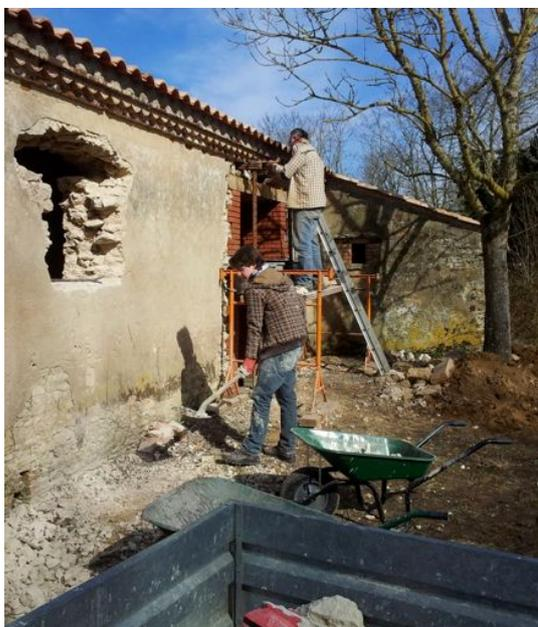
agrandi/faites les ouvertures dans la façade Est pour les fenêtres et les portes-fenêtres. On vous signale que l'épaisseur de ces murs est de 50 centimètres, 'faut le faire !!
